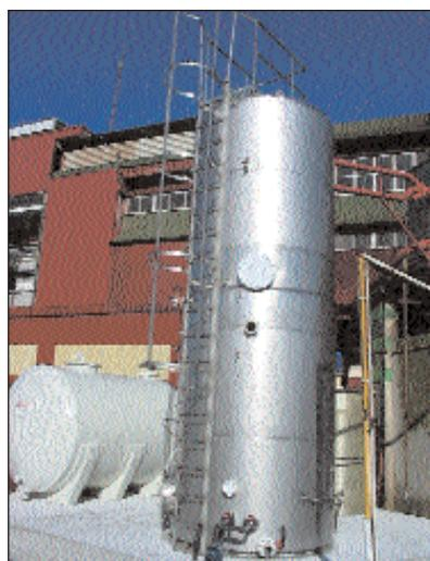
Figura 2. Fotografía del reactor híbrido.
