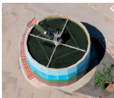
Filtro percolador de la EDAR de Albocácer.
