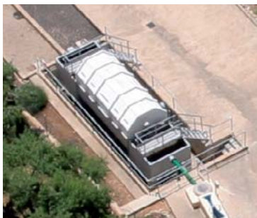
Biodisco de la EDAR de Vilar de Canes.
